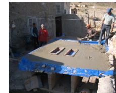
Coulage de la dalle intermédiaire - Juin 2010
