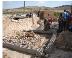
Travaux d'excavation - Juin 2010
