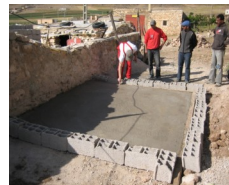
Coulage de la dalle de fondation - Juin 2010
