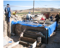
Construction des chambres et des marches - Juin 2010
